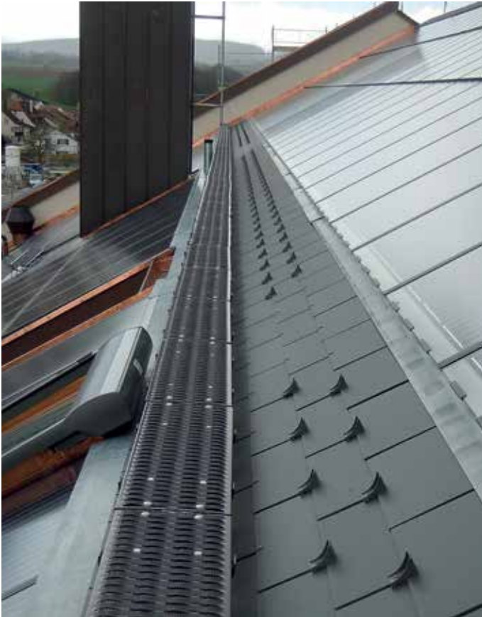
Begehbarer Rost zum Unterhalt und Schneefang
