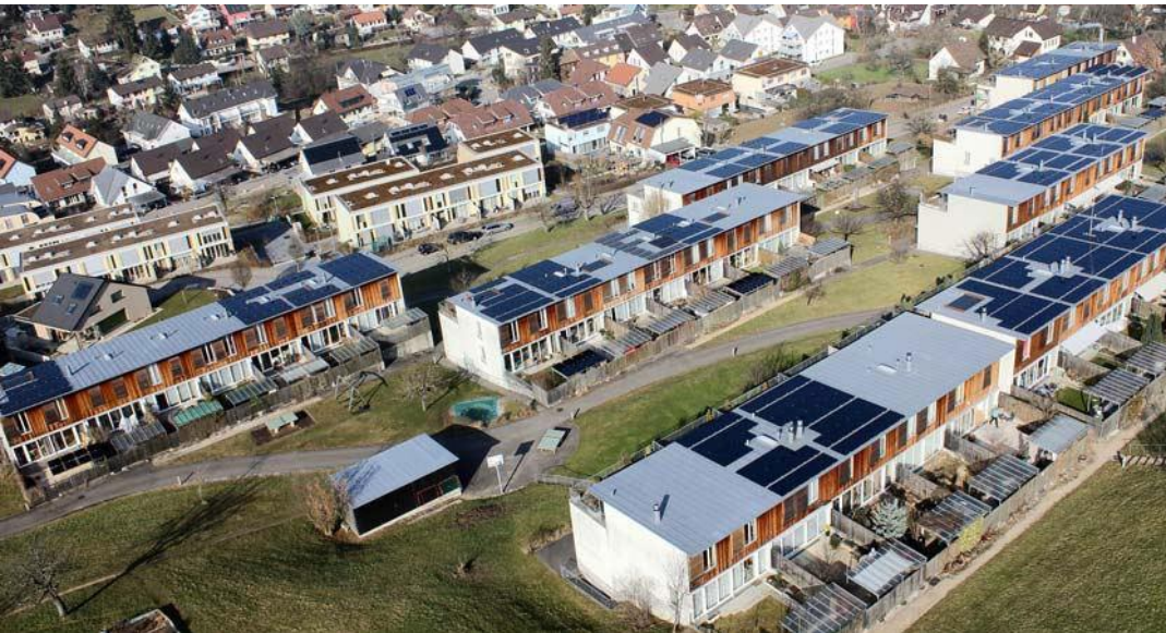
Bei der Überbauung «Eich» in Frenkendorf BL wird in Zukunft das Kapazitätsproblem durch eine dynamische Regelung von Blindleistung und Wirkleistung gelöst. (Foto: Solvatec AG)
