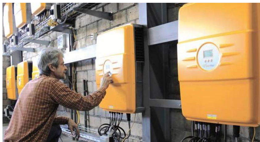
Die kontrollierte Einspeisung bzw. Aufnahme von Blindleistung durch den Wechselrichter ist eine Möglichkeit, die Netzspannung bei gleichzeitiger Einspeisung von Wirkleistung im zulässigen Bereich zu halten. Z.B. moderne SolarMax-Wechselrichter eignen sich aufgrund ihrer Schaltungstopologie sehr gut für diese Anforderung des Einspeisemanagements. (Foto: Sputnik Engineering AG)
